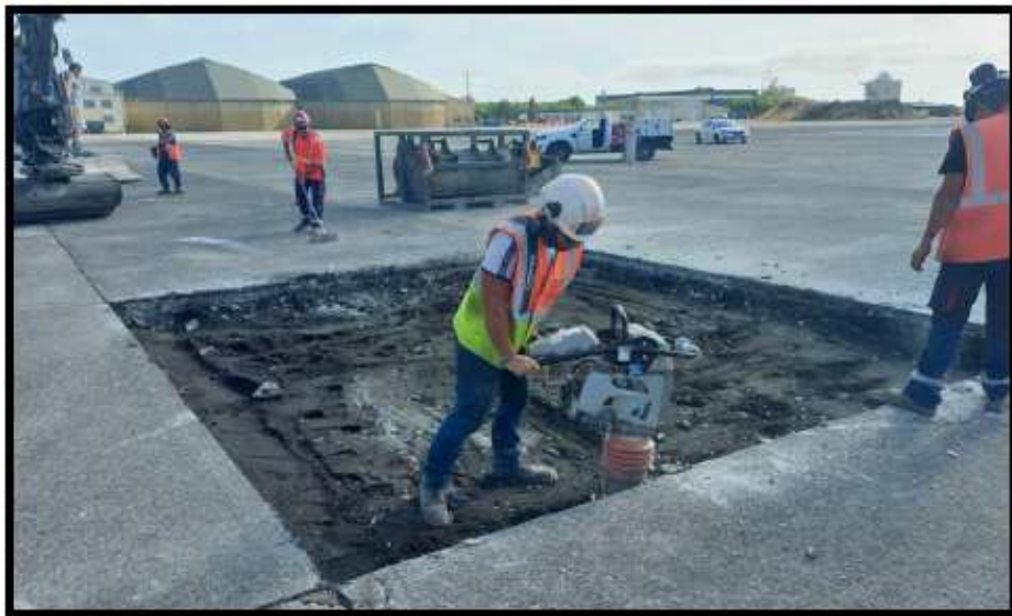
Photo 1: Décaissement dalle béton 5m/5m et compactage avant essais de portance (dynaplique et essais de plaque)
